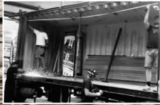
Bau von Gonzilla
