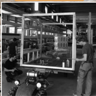
Aufbau in der Halle
