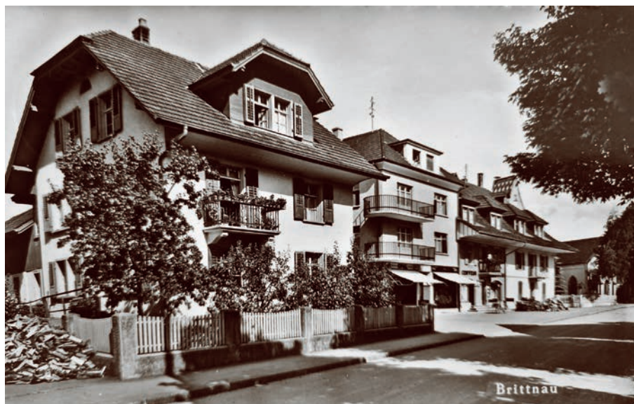
Blick von der Dorfstrasse Richtung Papeterie
